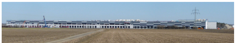
Das Lidl-Logistikzentrum Graben wächst rasend schnell
